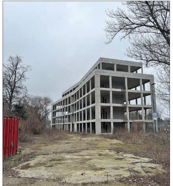
Die Bauruine an der Ernststraße hinter Rewe
