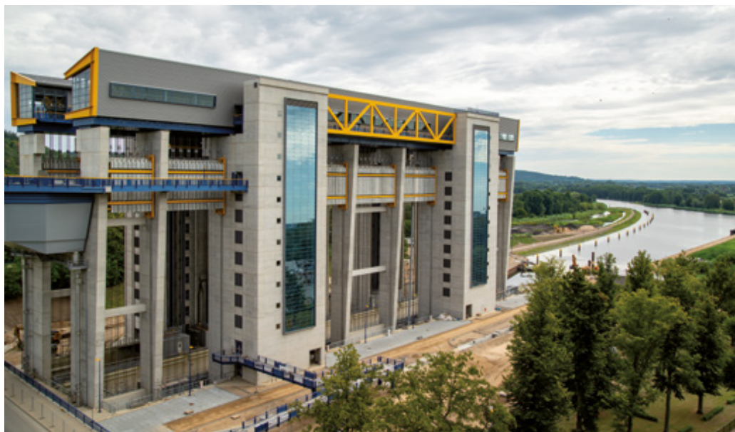
Neben dem 1934 eröffneten Schiffshebewerk Niederfinow entstand das Schiffshebewerk Niederfinow Nord, das für größere Schiffe geeignet ist, und 2022 eingeweiht wurde.
