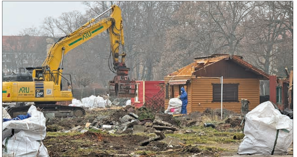
Bagger machen Parzellen in der Kleingarten-Kolonie an der Pankower Allee platt.
