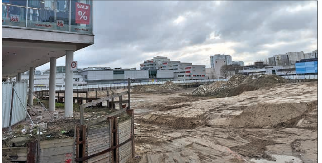
Die ewige Baustelle im Märkischen Zentrum: Im Herbst sollen hier wohl die Bauarbeiten starten.
