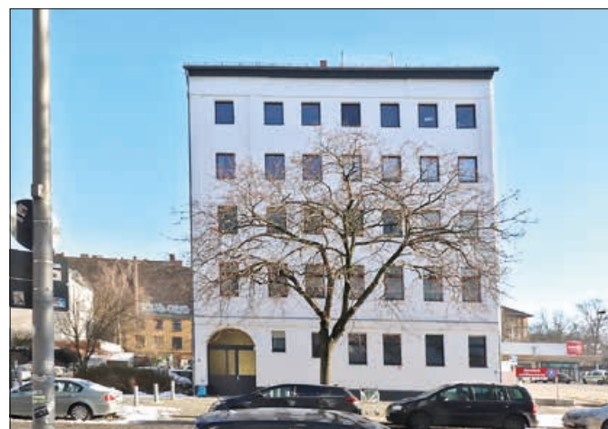
Die Wohnhäuser Gerichtstraße stehen im Gewerbegebiet. Foto: as
