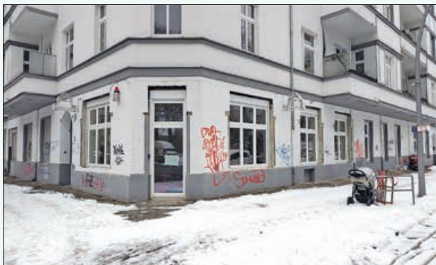
Noch sieht es von außen nach Umbau aus, innen ist der neue Kinderladen aber fertig.
