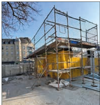
Der Eingang am U-Bahnhof Alt-Tegel ist eine Großbaustelle.
