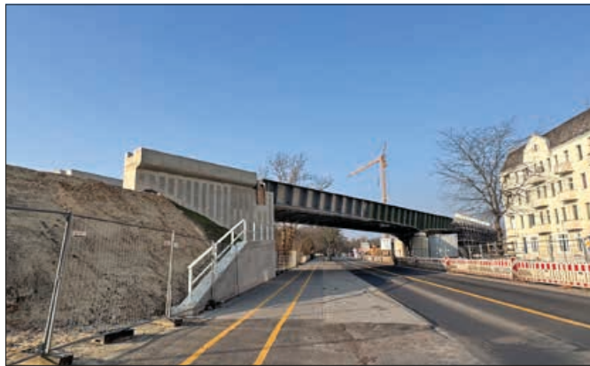
Die Brücke über die Scharnweberstraße ist fast fertiggestellt Fotos (2): fle
