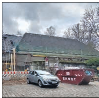
Baustelle in der Plantagenstraße: Hier entsteht das neue Kino Arsenal. Foto: dh
