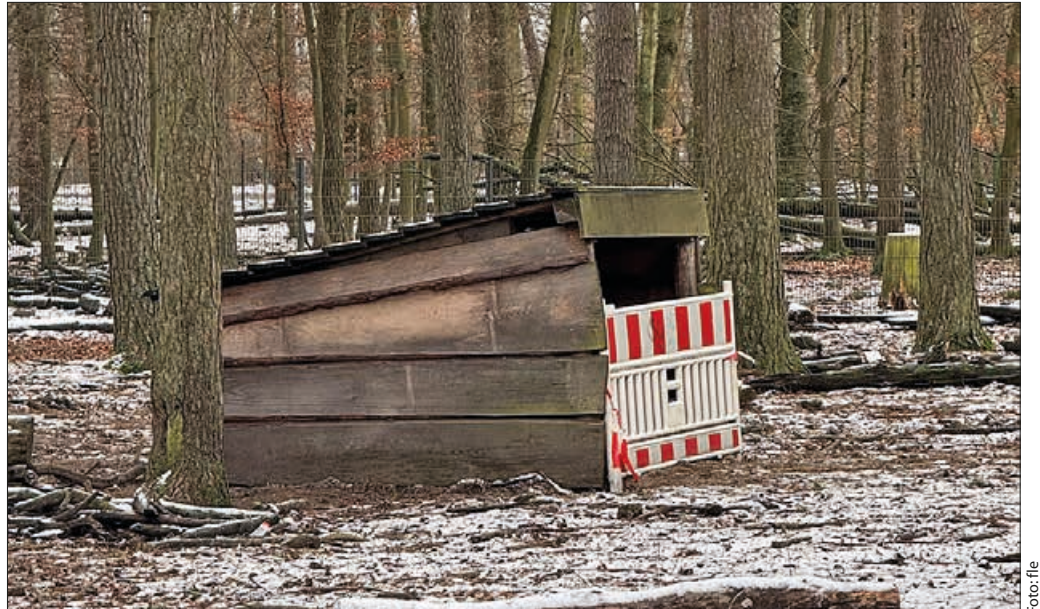
Absperrungen an den Schutzhütten – so sieht es zurzeit im Schwarzwildgehege am Schwarzen Weg aus. Foto: fle
