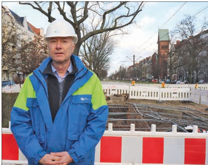
Stephan Natz von den Wasserbetrieben in der Seestraße Foto: as
