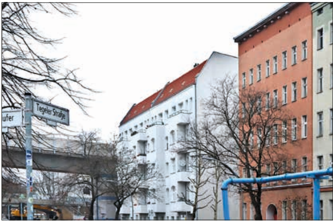
In der Tegeler Straße werden wohl bald Wohnhäuser abgerissen. Foto: as
