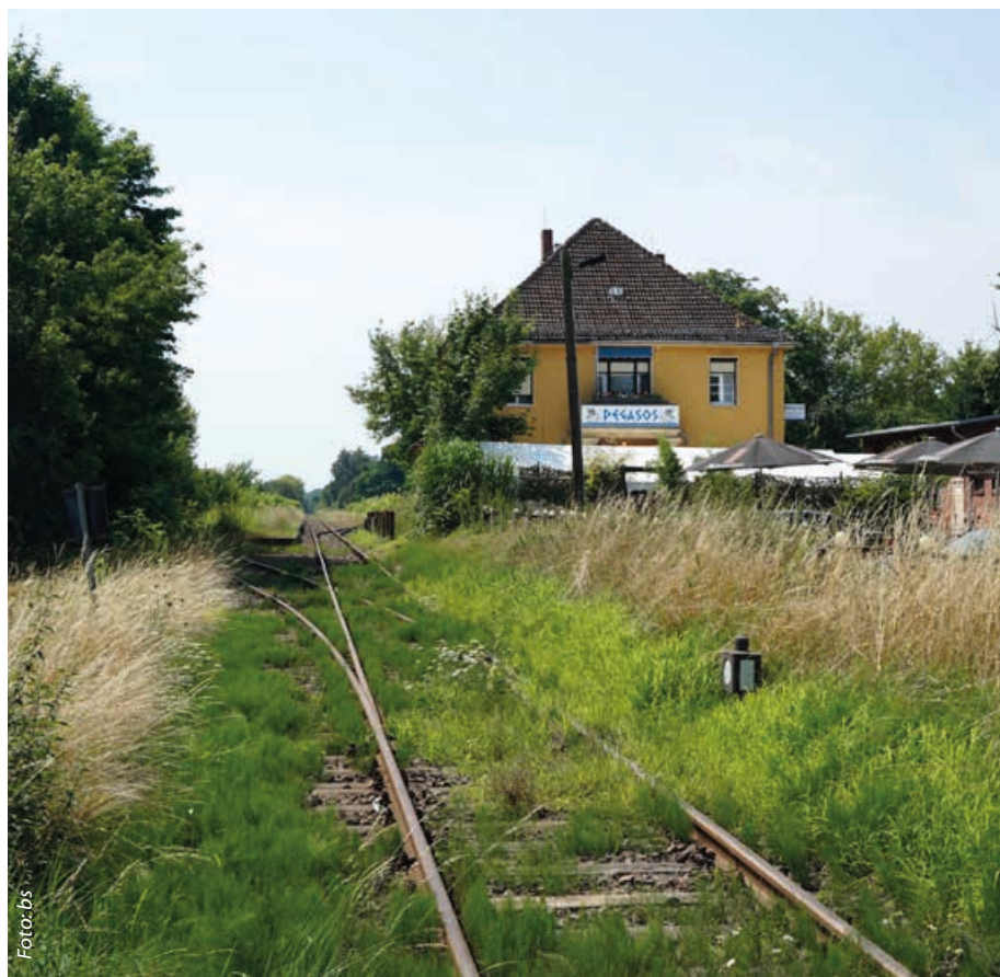
Überwucherte Gleise der Heidekrautbahn bei Mühlentopf
