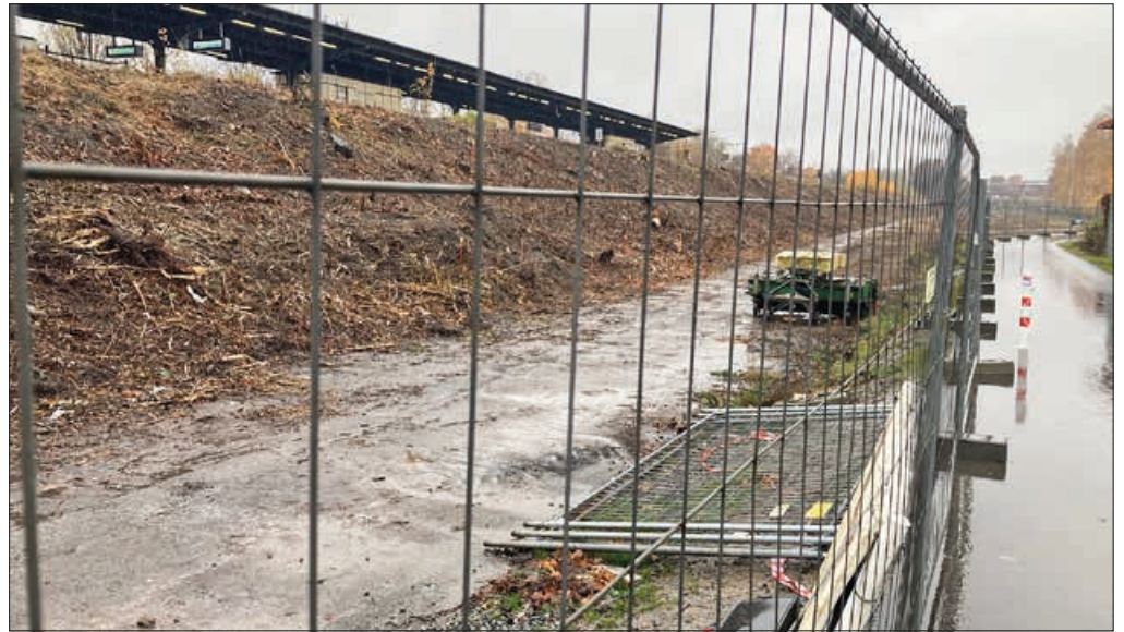
Abgesperrte Baustelle beim S-Bahnhof Wilhelmsruh.
