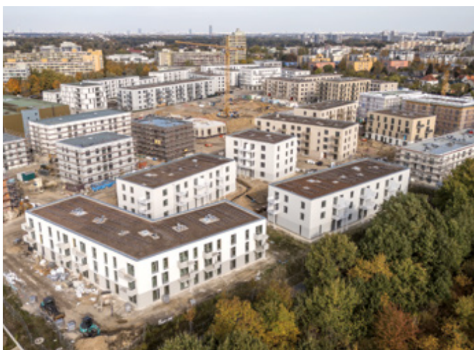
Neubauvorhaben Buckower Felder
