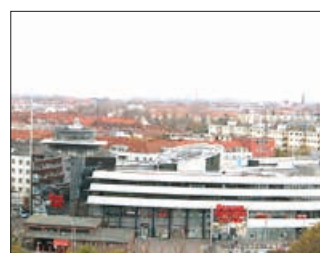
Auf das Dach des Gesundbrunnen-Centers wird demnächst ein Hotel aufgesetzt.
