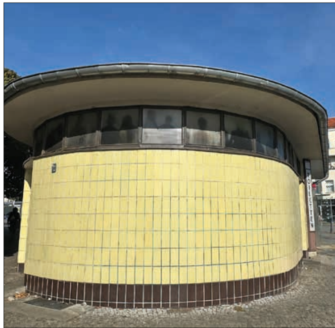
Der denkmalgeschützte Bau – vorne mit Kiosk und hinten mit Toilettenbereich
