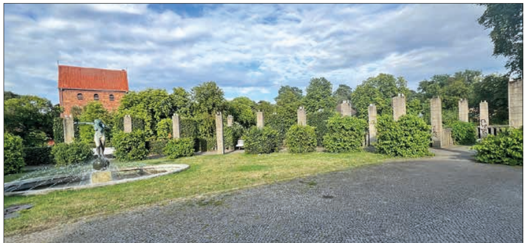
Die Pergola als Baustelle. Im Vordergrund links die Kugelläuferin.
