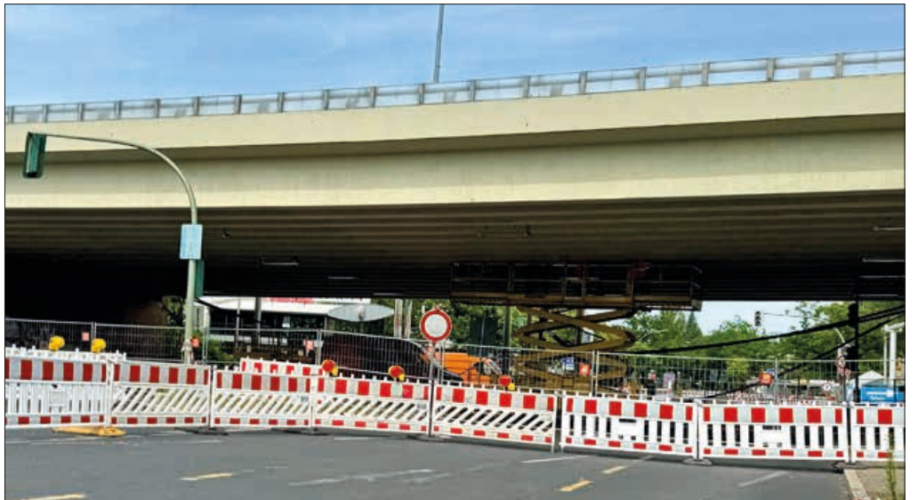
Die Sperrung der Holzhauser Straße dauerte mehrere Tage.
