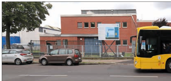
In der Holzhauser Straße wird ein neuer Netzknoten gebaut. Fotos (2): as
