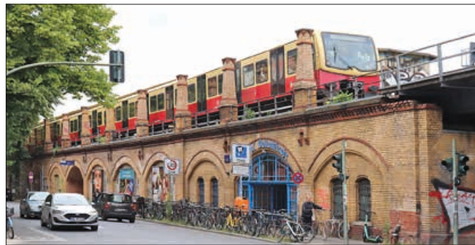
Bauarbeiten am S-Bahnhof Wollankstraße
