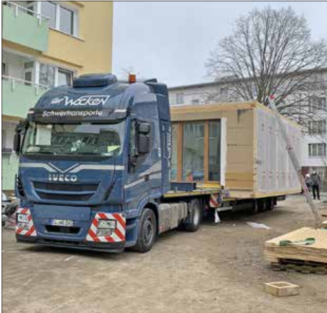
Der Schwerlasttransport bringt das fast fertige Modul.
