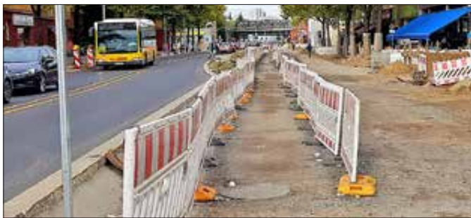
Die Baustelle in der Oranienburger Straße beeinträchtigt auch die Müllabfuhr. Foto: Wohlert
