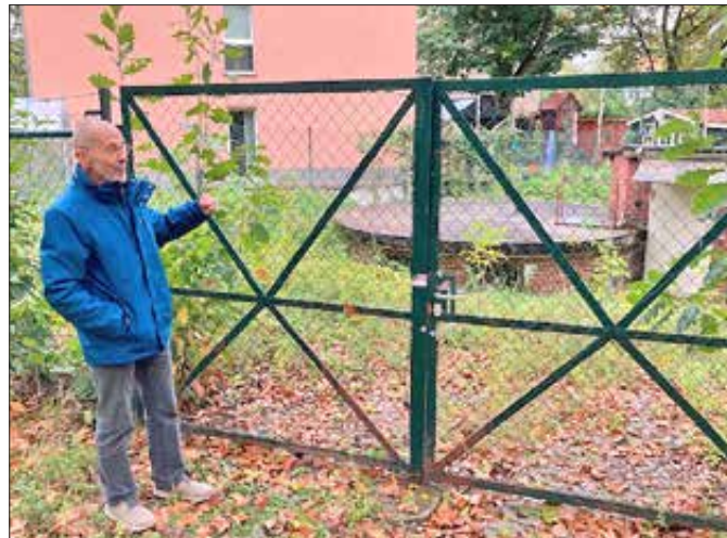
Gerd Pätzold vor dem Hebewerk
