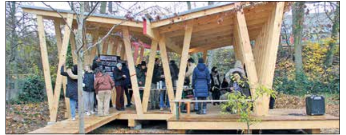
Das grüne Klassenzimmer ist ein überdachtes Holzbauwerk. Foto: dh
