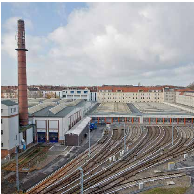
Blick ins Hauptbetriebswerk Seestraße Foto: BVG/Oliver Lang
