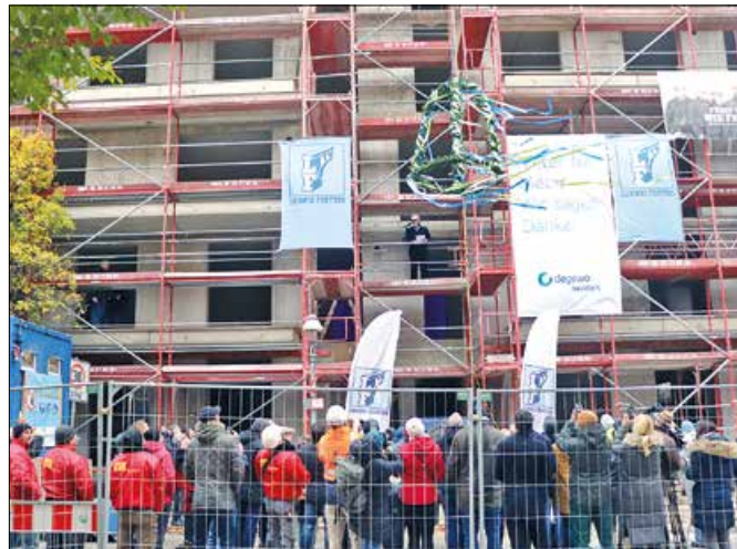
Viele Besucher versammelten sich vor dem Rohbau, über ihren Köpfen schwebt der Richtkranz. Fotos (2): as
