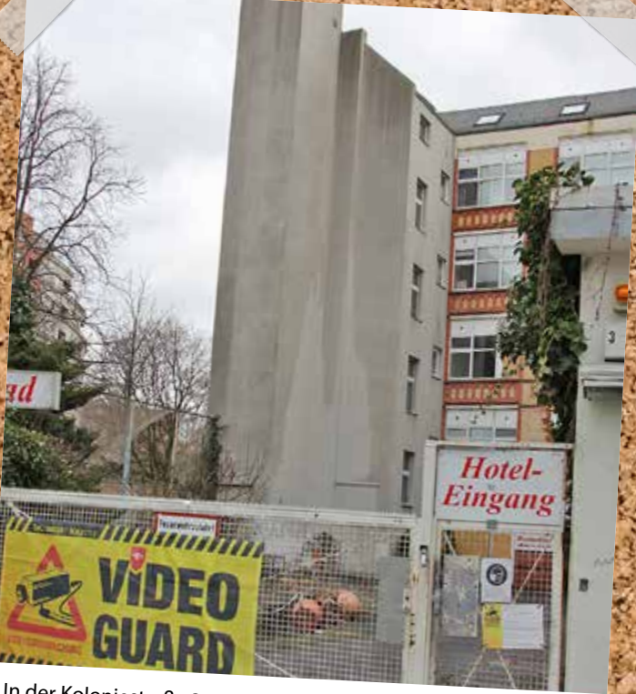
In der Koloniestraße 3-4 soll eine Lücke geschlossen und ein Neubau errichtet werden. Das Haus wird nahe der Einmündung zur Schwedenstraße direkt am Hotel am Luisenbad gebaut. Auf 2.028 Quadratmetern soll ein modernes Bauensemble entstehen, dass sich aus einem zur Straßenseite ausgerichteten Neubau und einem bereits bestehenden Loftgebäude mit Remise zusammensetzt. Der Baubeginn ist für Anfang April geplant. dh
