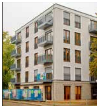
Der Neubau in der Amendestraße ist fertig.
