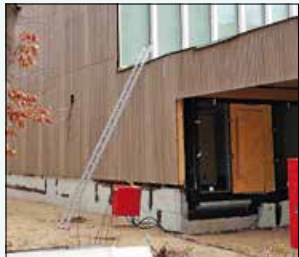
Die Sporthalle in der Putbusser Straße ist fast fertig. Foto: dh
