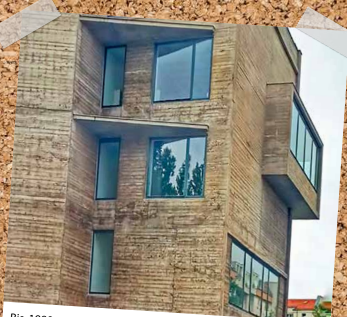
Bis 1989 produzierte Rotaprint Druckmaschinen im Wedding zwischen Gottsched- und Wiesenstraße. Nach dem Konkurs des Unternehmens fiel das Gelände einer Bürgerschaft des Senats an den Bezirk. Kurz danach wurde das Ensemble aus gründerzeitlichen Gewerbegebäuden und den Erweiterungsbauten aus den fünfziger Jahren unter strengen Denkmalschutz gestellt. Es gilt als herausragendes Beispiel der Berliner Nachkriegsmoderne. Das Gelände wurde viele Jahre vernachlässigt. 2004 startete ExRotaprint als Mieterinitiative. Nach erfolgreichen Kaufverhandlungen beschloss der Verein die Gründung der gemeinnützigen GmbH ExRotaprint. Foto: Joachim Faust/ Weddingweiser
