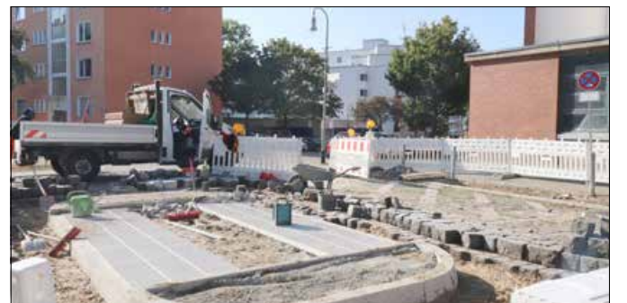
Baustelle für Verkehrsinsel auf der Hussitenstraße
