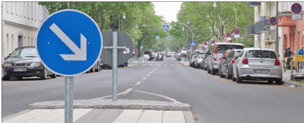
Die neue Soldiner Straße ist nach dreijähriger Sanierung schöner und bequemer.
