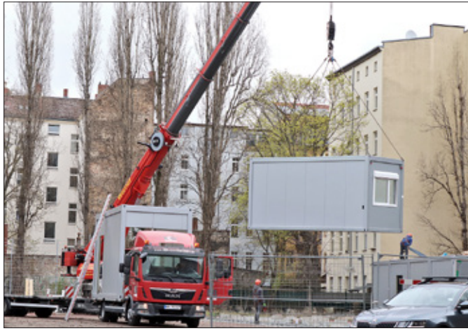
Provisorisches Ausweichquartier für die VHS
