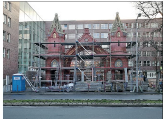
Das Beamtentor wird jetzt saniert.
