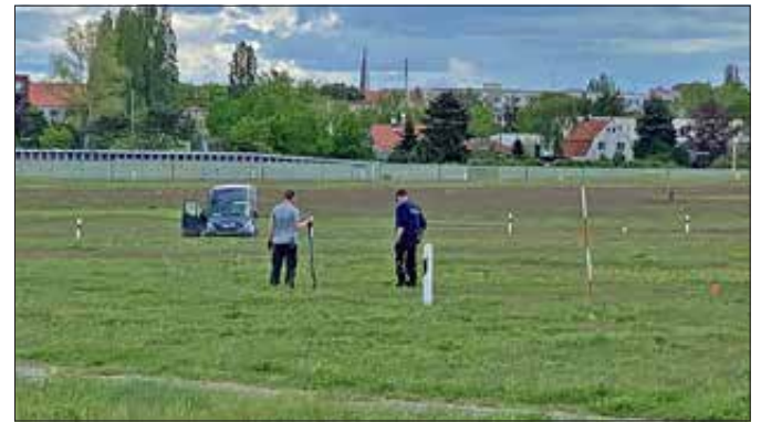
Dem Baggern geht die Sondierung des Geländes voraus.
