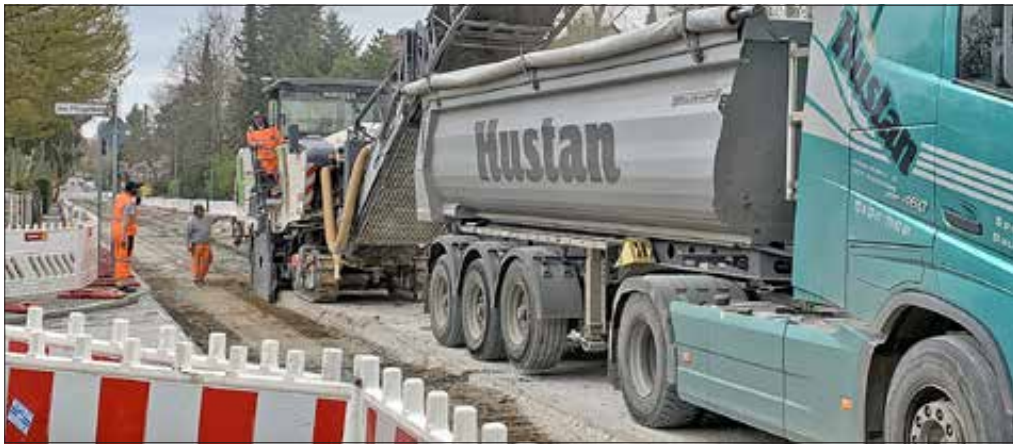
Vor dem Flüsterasphalt kommt der Lärm durch die Baufahrzeuge
