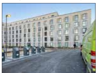
Auch nicht viel hübscher: Neubaubau nach Nord-Bowling-Abriß.
