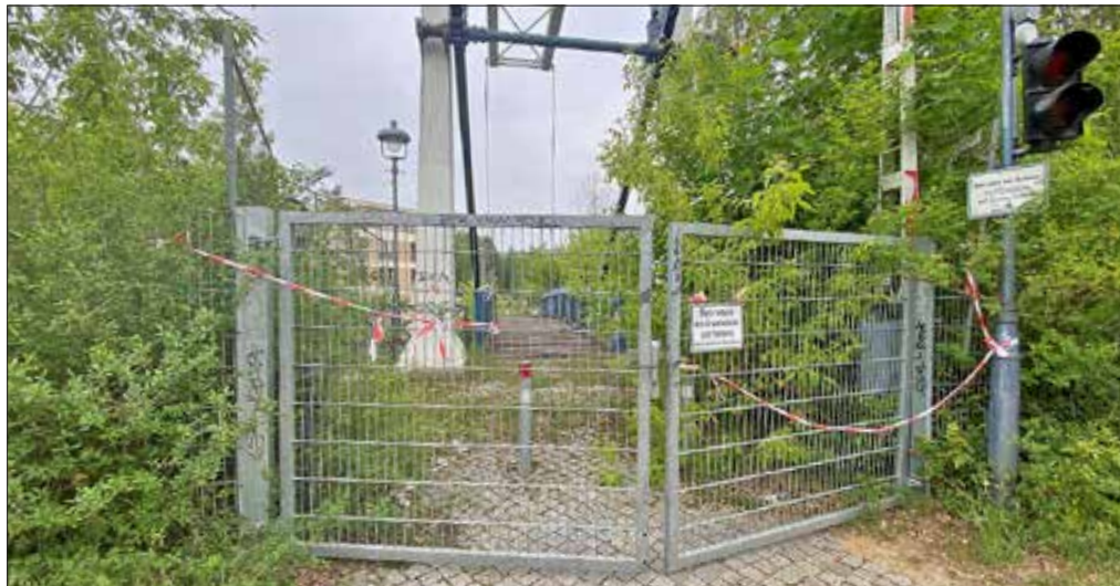
Die Hubbrücke soll im Dezember wieder für Fußgänger geöffnet werden.
