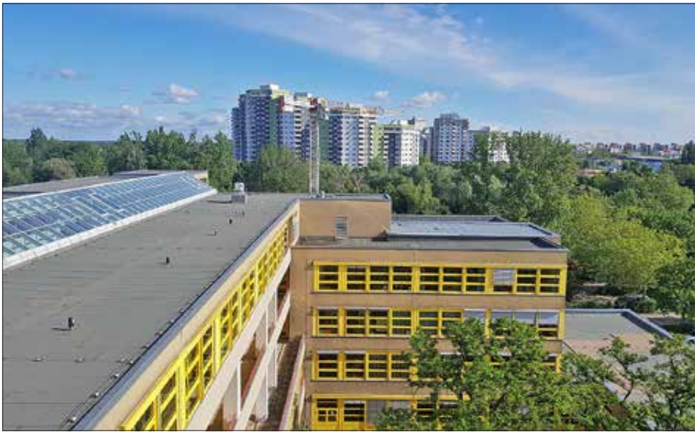
Auf dem Dach des Thomas-Mann-Gymnasiums wird eine Solaranlage installiert
