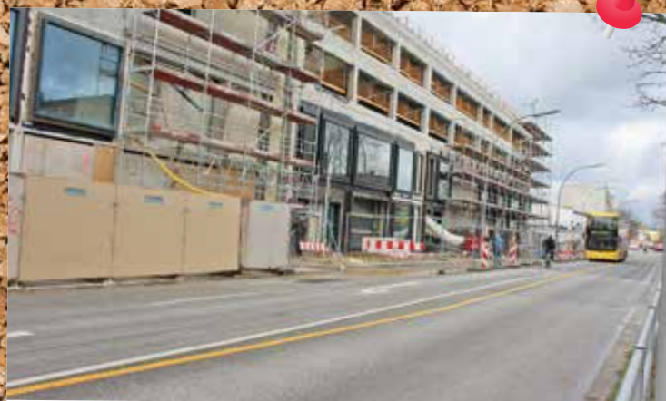
Die Buddestraße in Tegel ist wegen der Bauarbeiten am Tegel Center auf einen Fahrstreifen verengt, Staus sind vorprogrammiert. Diese Einschränkungen werden noch einige Zeit andauern. Foto: Madeleine Masoudi
