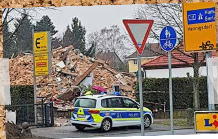
Am Samstagmorgen, 8. März, ist ein Mehrfamilienhaus in Hohen Neuendorf explodiert. Es gibt zwei Tote, drei leicht und einen schwer Verletzten. Das Haus muss wegen Einsturzgefahr abgerissen werden. Für die jetzt wohnungslosen Bewohner hat die Stadt ein Spendenkonto unter dem Kennwort „Hohen Neuendorf hilft“ eingerichtet: Konto der Stadt Hohen Neuendorf, Mittelbrandenburgische Sparkasse, IBAN: DE68 1605 0000 3704 0485 09, BIC: WELADED1PMB. Foto: Falko Hoffmann
