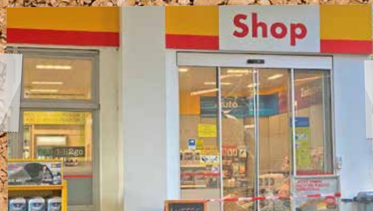
Am 4. März mussten die Kunden der Tankstelle Ecke Hermsdorfer Damm/Frohauer Straße am Nachtschalter ihre Rechnung bezahlen. In der Nacht war die Tankstelle überfallen worden, der Tresor wurde entwendet. Die Glastüren waren eingeschlagen und hingen nur noch in den Angeln. Foto: fle
