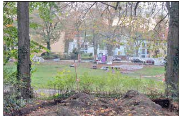
Noch Baustelle – im Mai soll der Spielplatz eröffnet werden.
