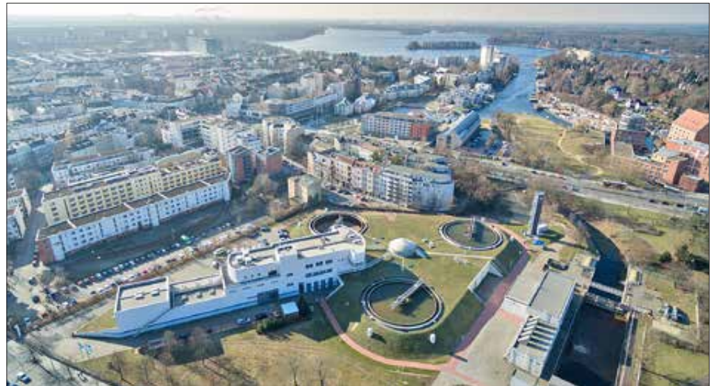
Die Oberflächenwasseraufbereitungsanlage (OWA) Tegel aus der Luft
